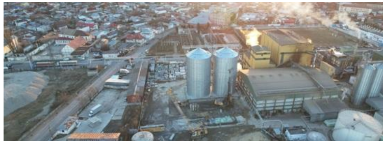
Complex de silozuri, Galati
