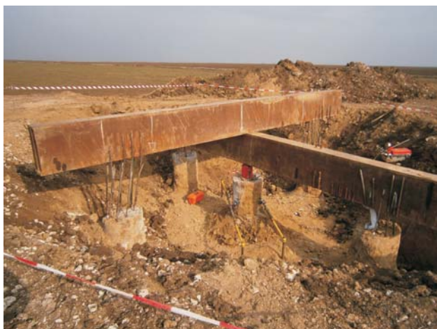
Executia testelor de compresiune pe piloți
