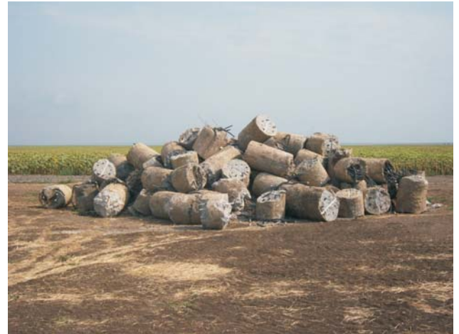
Capetele pilotilor rezultate in urma spargerii
