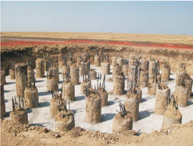
Platforma pregatita pentru spart cu stratul de beton de egalizare turnat
