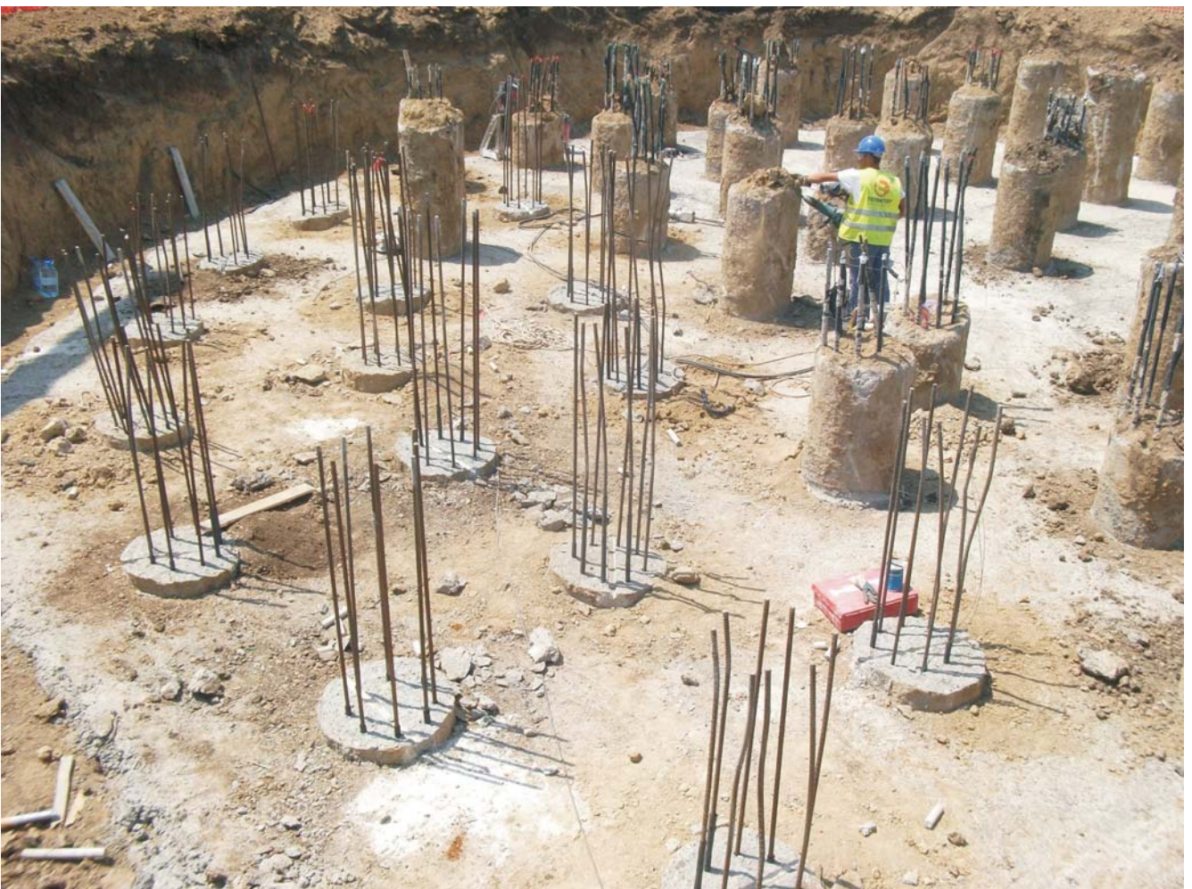
Procedeeul de spargere a capetelor pilotilor
