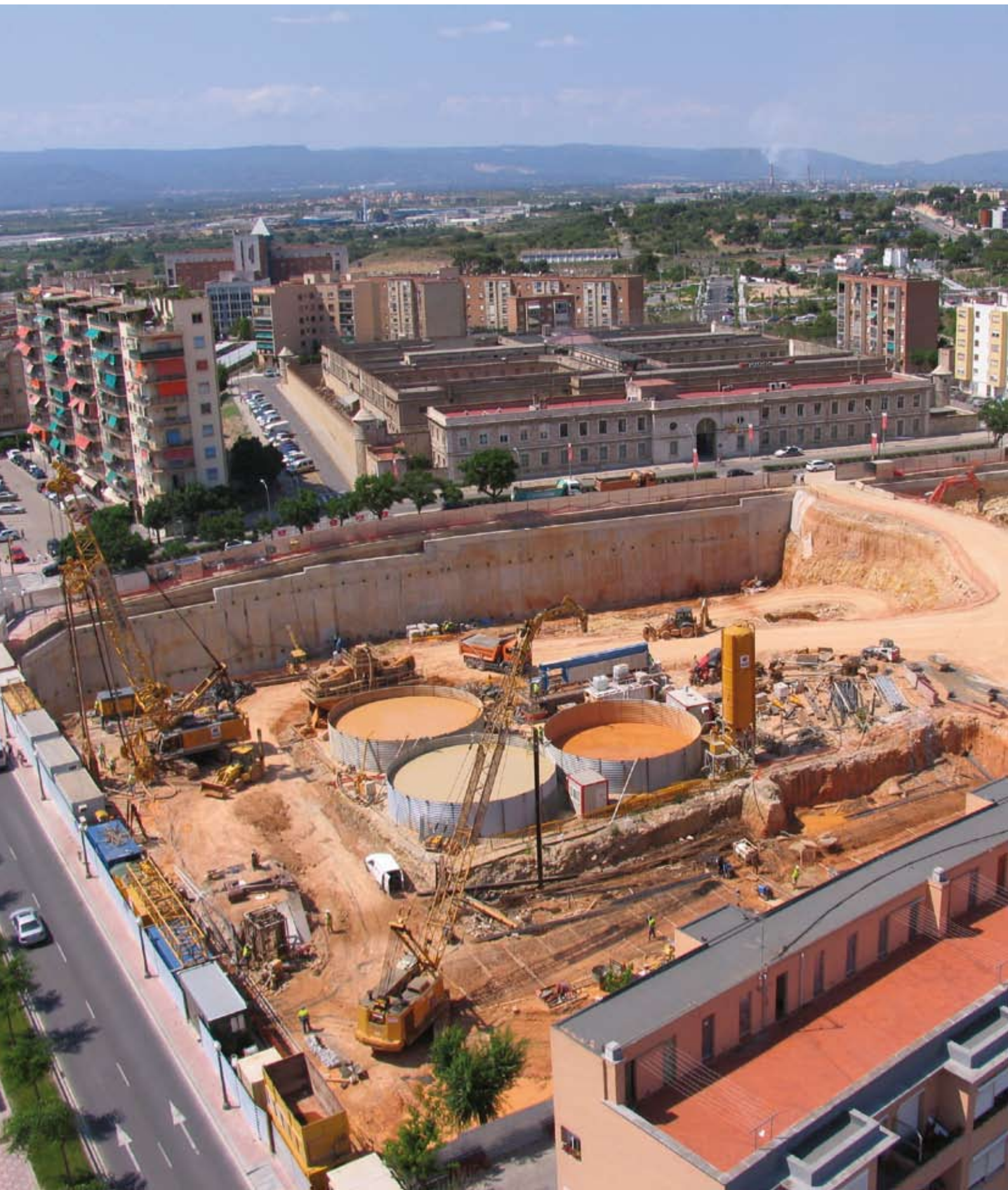
Corte Inglés Mall, Tarragona, Spain Diaphragm walls
