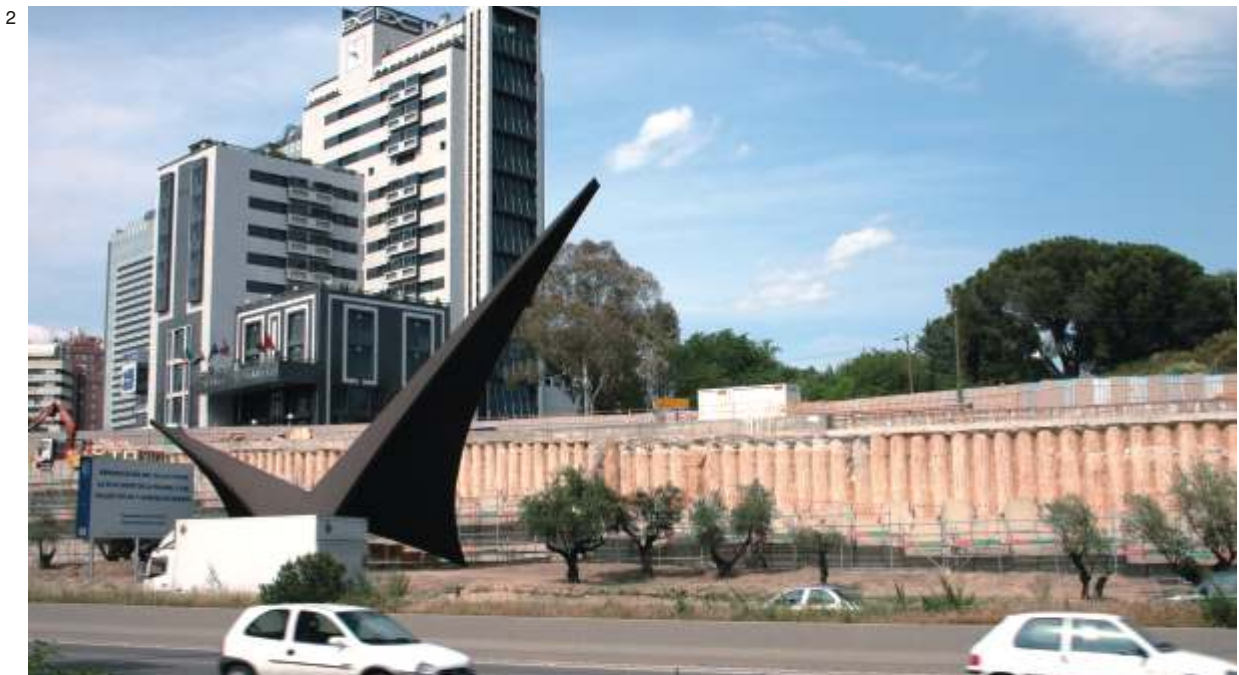
1. Retaining using a pile wall for the El Corte Inglés Shopping Centre in Pamplona (Navarra)
