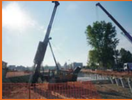
Piloți prefabricați Varianta de ocolire Vidin
