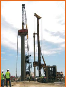
Piloți "in situ" Varianta de ocolire Vidin
