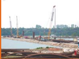
Piloți "in situ" Pod peste Dunăre Vidin - Calafat
