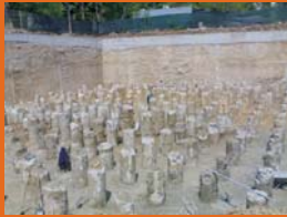
Pereți mulați. Piloți "in situ" Anamblul rezidențial Mareșal Alexandru Averescu - București
