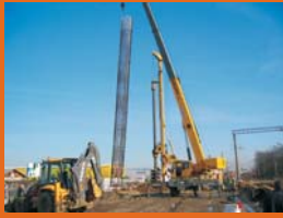
Piloți "in situ" Pod peste calea ferată Centură - București
