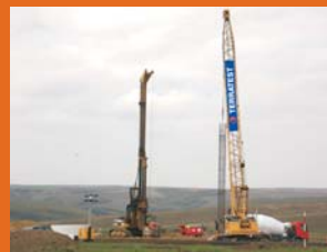
Piloți "in situ" Valea Nucarilor Windfarm
