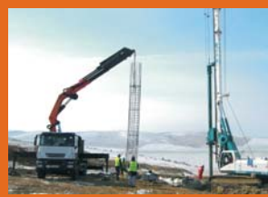
Piloți "in situ" Peștera Windfarm
