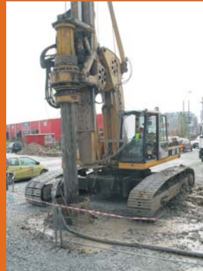
Piloți "in situ" Injecțare piloț Test încercare statică Pasaj Tunari - Centură București
