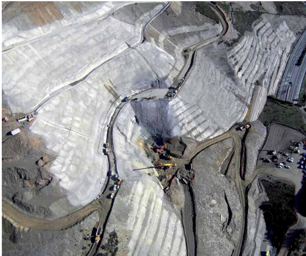
Lucrări de reabilitare pentru alunecarea de teren de pe autostrada A-6. León, Spania Ancore
