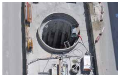
Injecții de compactare
