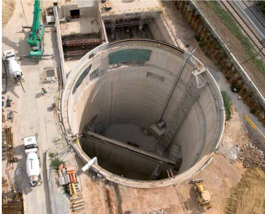
Metrou Barcelona, Linia 9. Gara Torrassa. Barcelona, Spania Trench Cutter
