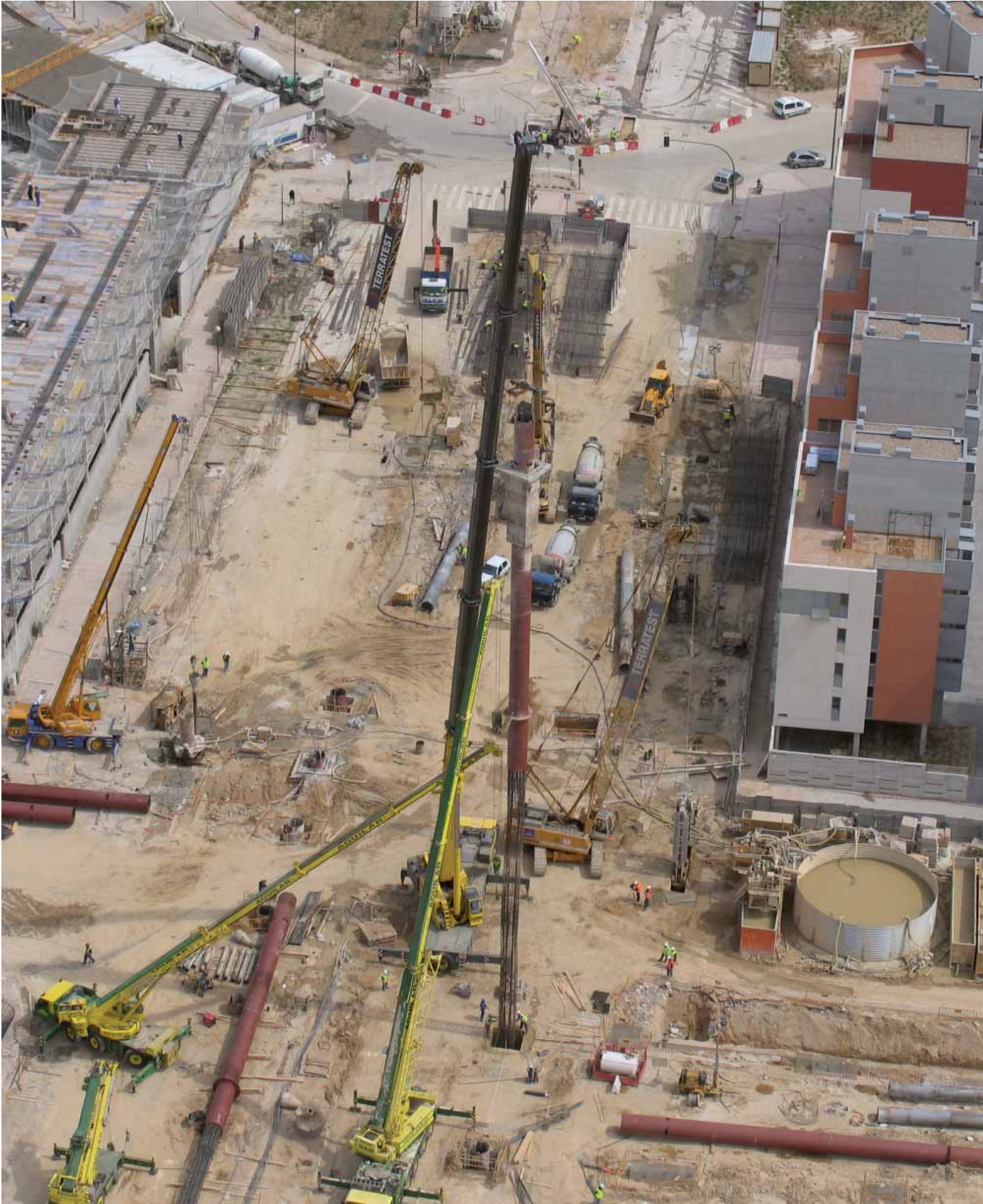
Metrou Nord, Segment 1A. Madrid, Spania Piloți foraj și Pereți mulați
