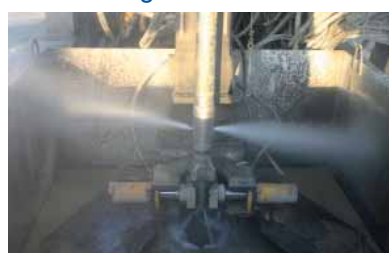
Injecții de compensare
